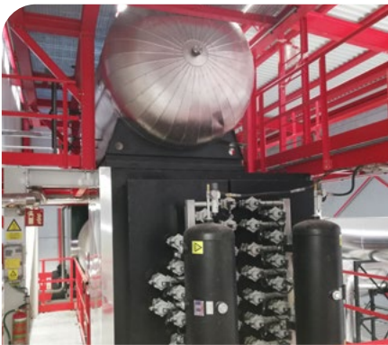
Intercambiador con limpieza automática en ambos pasos de humos. Tanque de vapor independiente. Incluye controles de niveles de presión, control de salinidad y purgas.
