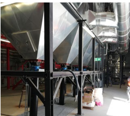
Filtro de mangas para la separación de partículas de los gases de combustión
