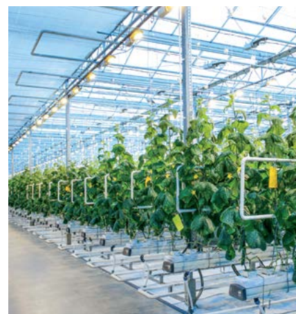
Proyectos de climatización para invernaderos y grandes espacios.
