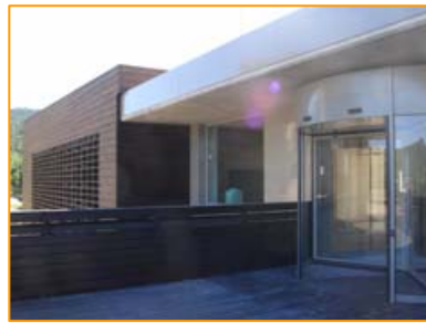
ENTRADA DEL EDIFICIO
